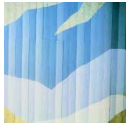
Bild 20: Betonoberfläche mit deckender Beschichtung, Acrylharzfarbe
