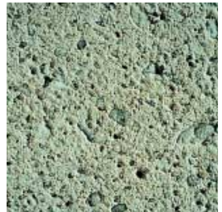
Bild 7: Gestrahlte Betonoberfläche, Singhofener Quarzit 0-16 mm, weißer Zement, 0,2 % Eisenoxidgelb
