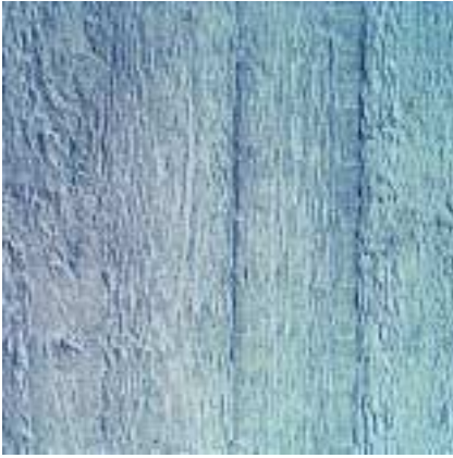
Bild 2: Rauhe Betonoberfläche, sägerauhe Brettschalung, grauer Zement
