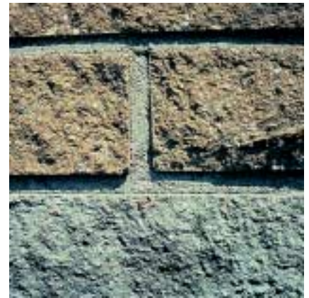
Bild 13: Gespaltene Betonoberfläche (Steine), heller Zuschlag, weißer Zement
