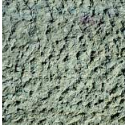
Bild 9: Gespitzte Betonoberfläche, Rheinkies, grauer Zement
