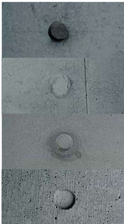
Ankerloch, mit Faserzementstopfen.
