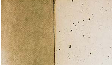
Grauer Beton mit Faservlies bzw. glatter, nicht saugender Schalhaut hergestellt.
