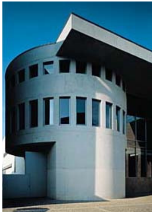
Scharrierter, weißer Ortbeton.
