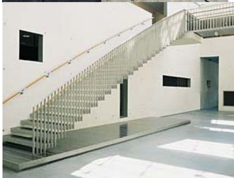
Schalungsglatter Sichtbeton mit Weißzement und Marmormehl.
