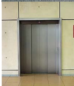
Schalungsglatte Betonfertigteile mit Scheinkonen.
