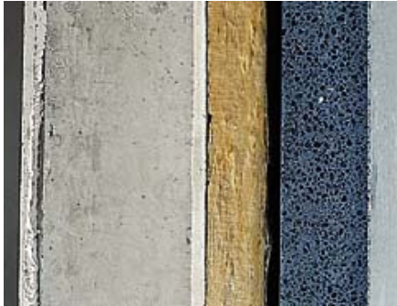
Bild: Wandaufbau mit vorgehängter Fassadentafel, Putz / Ortbeton / Wärmedämmung / Luftschicht / vorgehängtes Betonfertigteil (ohne Hinterbeton).
