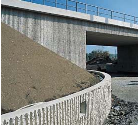
Grauer Ortbeton mit Strukturmatrize hergestellt.
