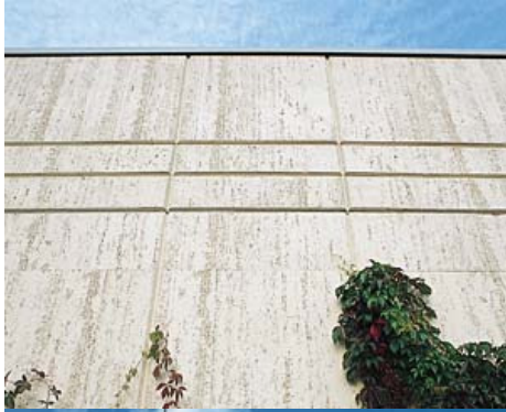
Großformatige Betonfertigteile mit Travertinstruktur.
