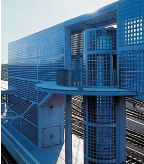
Schalungsglatte, blaupigmentierte Betonfertigteile.
