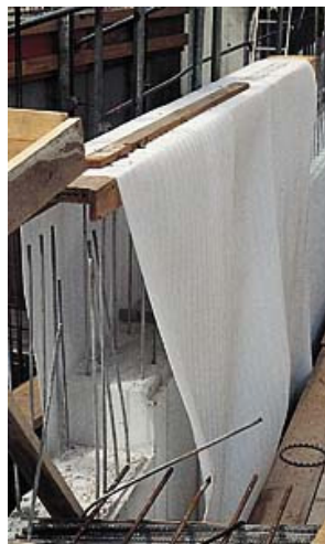
Schutz/Nachbehandlung von Sichtbeton.
