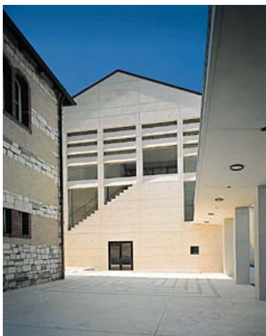
Weißbeton mit abgedichteten Schalungsstößen hergestellt.
