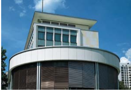
Kleinformatische, vorgehängte Betonwerksteinplatten.
