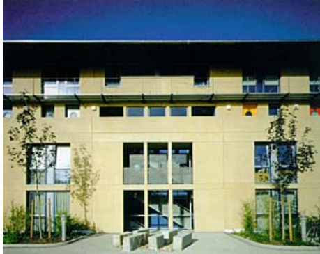
Betonfertigteile mit sandsteinartiger Oberfläche.
