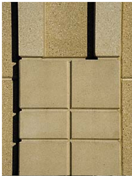
Ausschnitt einer Fassade: Unterschiedliche Oberflächenbearbeitungen eines Betons (feingeschliffen, gesäuert, feingewaschen).
