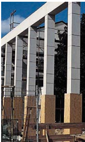
Schutz von scharfkantigen Betonbauteilen.
