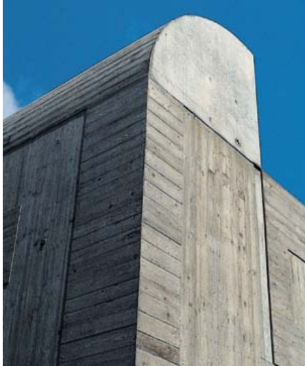
Horizontale und vertikale Brettschalung.
