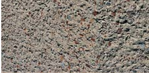
Gespitzte Betonwerksteinoberfläche.
