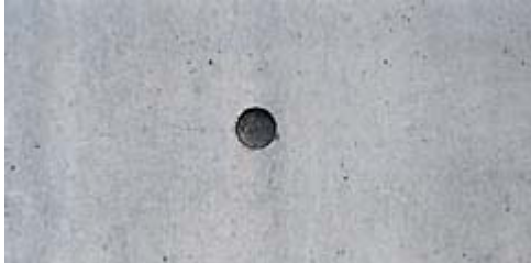
Grauer Ortbeton, glatte, nicht saugende Schalhaut, übliche Farbvariationen.
