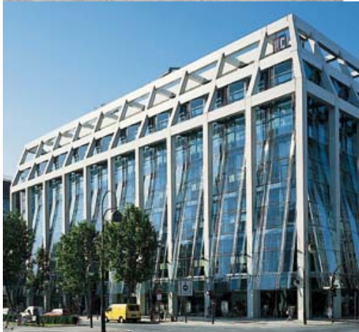
Schalungsglatte Schleuderbetonstützen.
