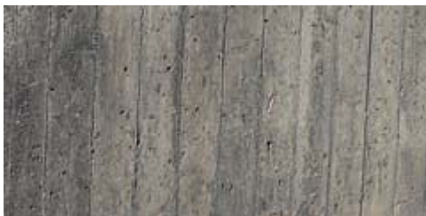
Grauer Ortbeton, gehobelte, saugende Brettschalung.
