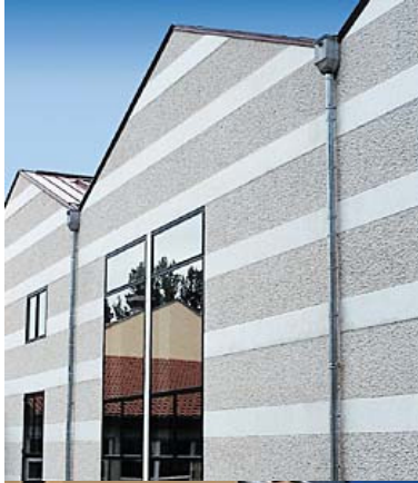
Gespitzter und schalungsglatter Ortbeton.
